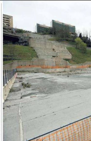
▲ Vuoto Un particolare della zona dopo le demolizioni della Diga di Begato e in attesa della nuova rigenerazione
